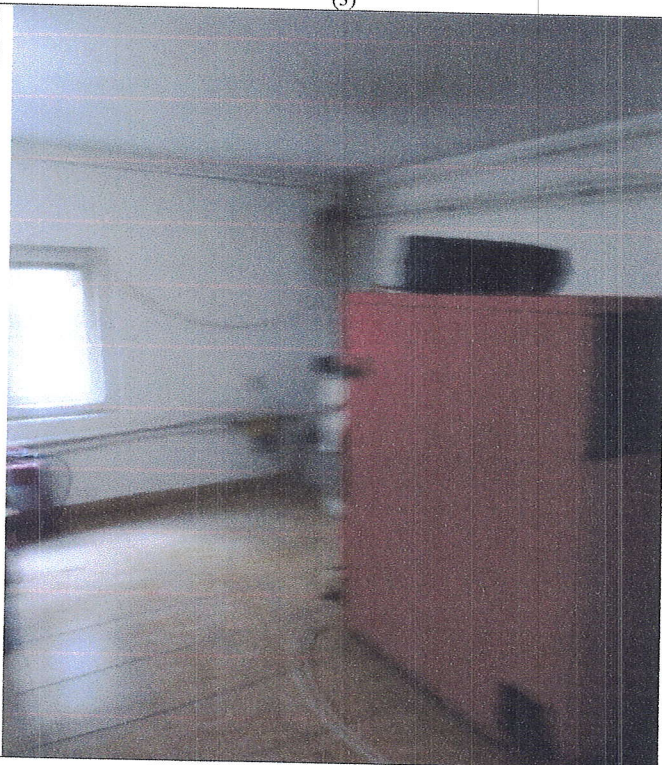
Interioare subsol - CT (5)
